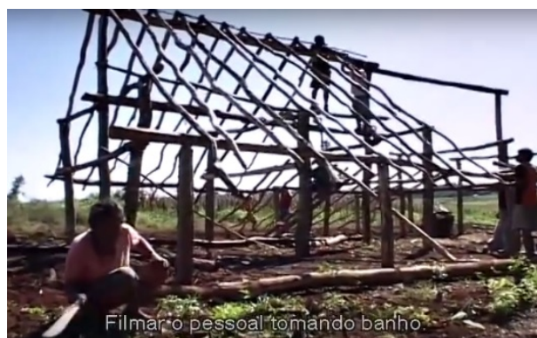
Figura 3. Construção da Casa de Reza
